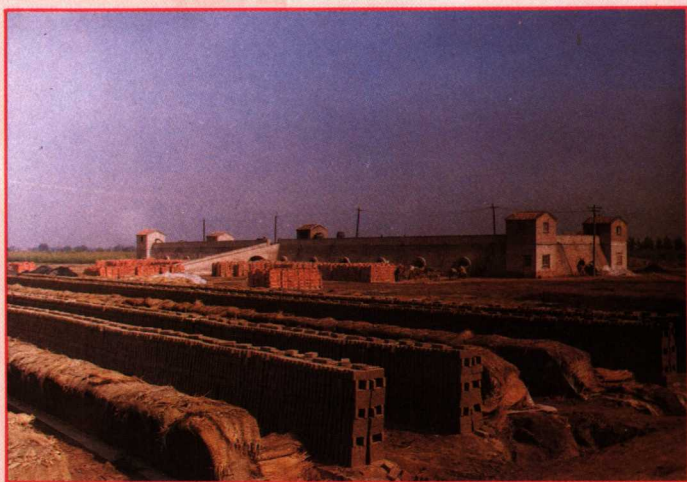
孙庵乡南梁砖瓦厂
