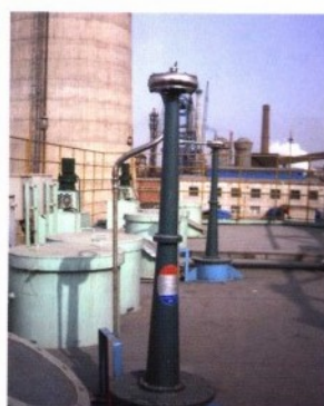
SQ-75型声波清灰器用于电除尘器极板、极线清灰
