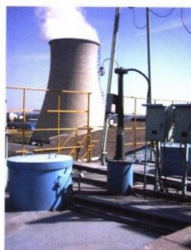
SQ-75型声波清灰器用于电除尘器极板、极线清灰
