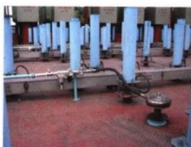
SQ-75型声波清灰器在顶部电磁振打电除尘器增效改造中的应用
