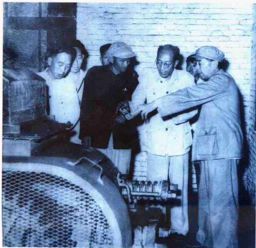
1959年6月30日周总理视 察峰峰矿务局二矿简易洗煤厂。
