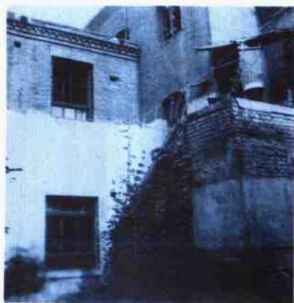
1948年至1956年新华街路南办公楼旧址一角
