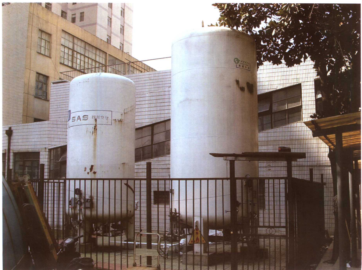
彩图 16 液氧气化集中供氧(液氧贮槽)
