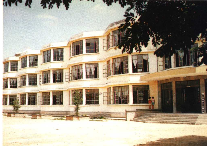
临沐镇第一小学教学楼
