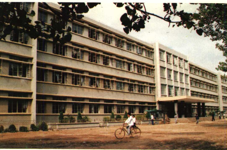
临沐一中教学楼
