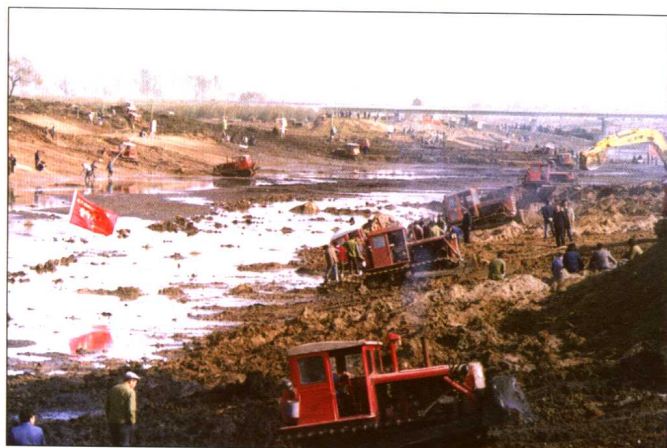
凉水河治理工程
