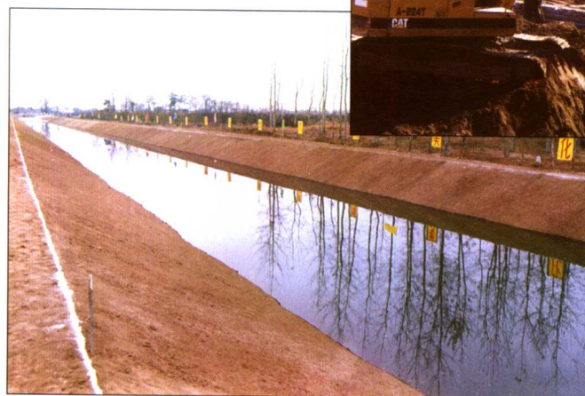
竣工后的胡各庄丰榆沟
