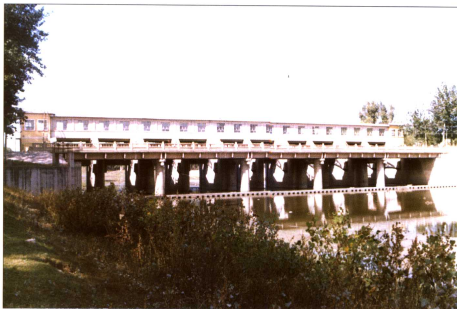
北运河北关分洪闸
