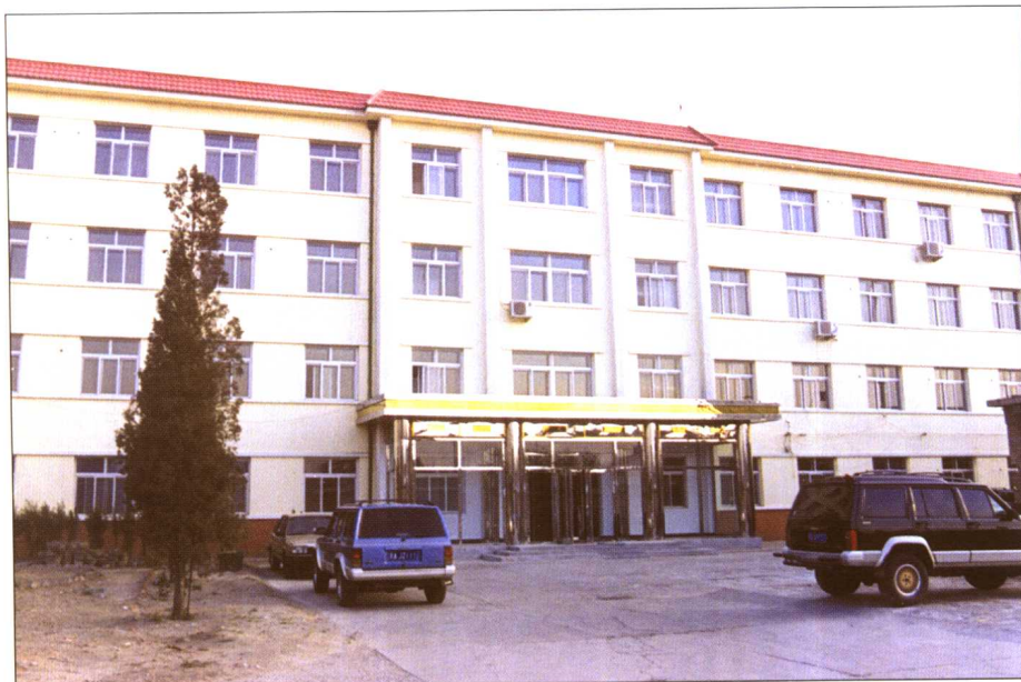
通州区水利局办公楼
