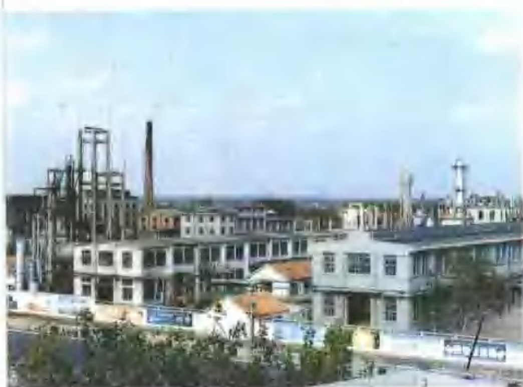
化肥厂区一角
