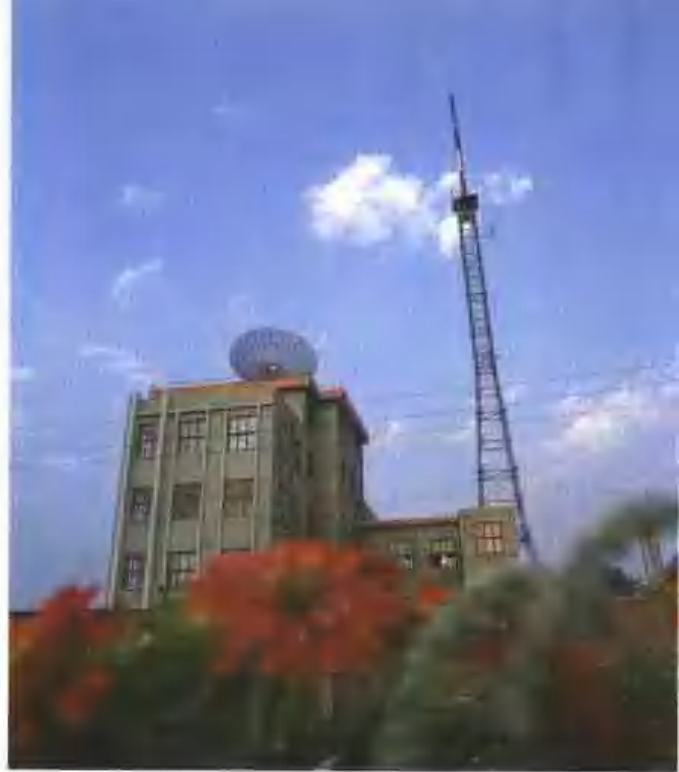
广播电视大楼
