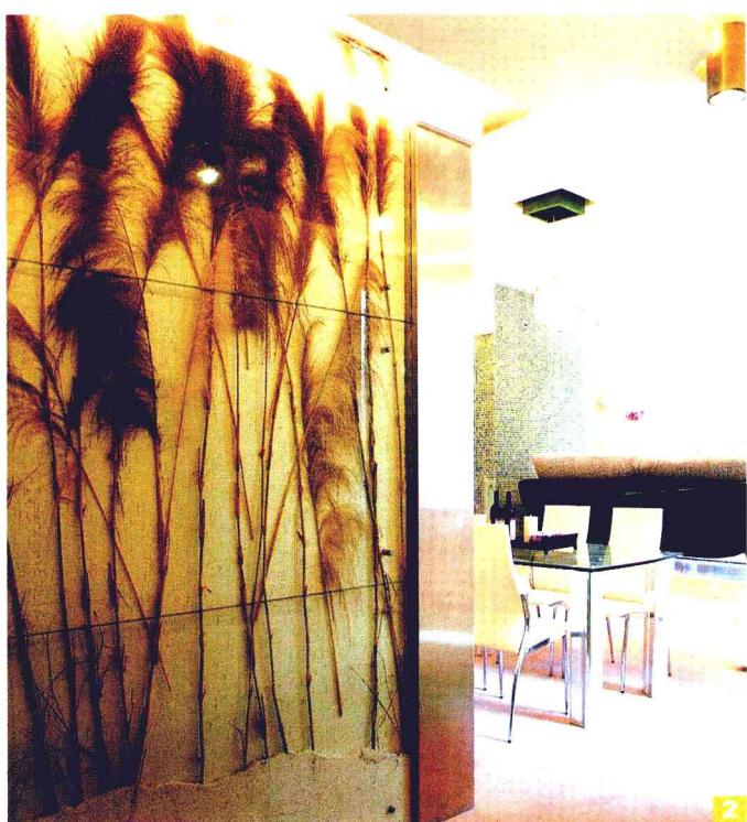
**2** 过道墙面为钢化玻璃材质。施工做法为：先用大芯板做为底材，按设计图纸用钢钉固定在墙上，表面刷清漆，注意固定时各大芯板块之间留5毫米缝隙。之后粘贴成品装饰干枝，最后用专用玻璃连接件将钢化玻璃与墙面连接。整体造价大约在2000元/项。
