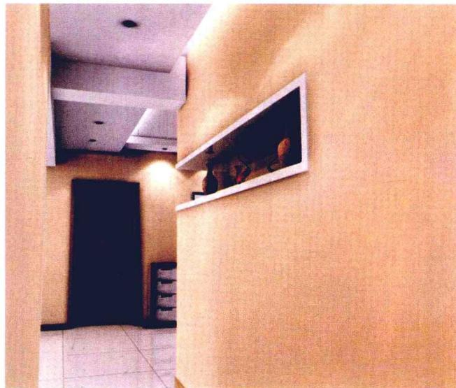
2 墙面造型为石膏板材质。施工做法为：先用木龙骨做出框架及结构，之后用石膏板封面，自攻螺钉固定，然后造型凹槽处用实木线条包边，最后石膏板表面刷乳胶漆。整体造价大约在750元/项。
