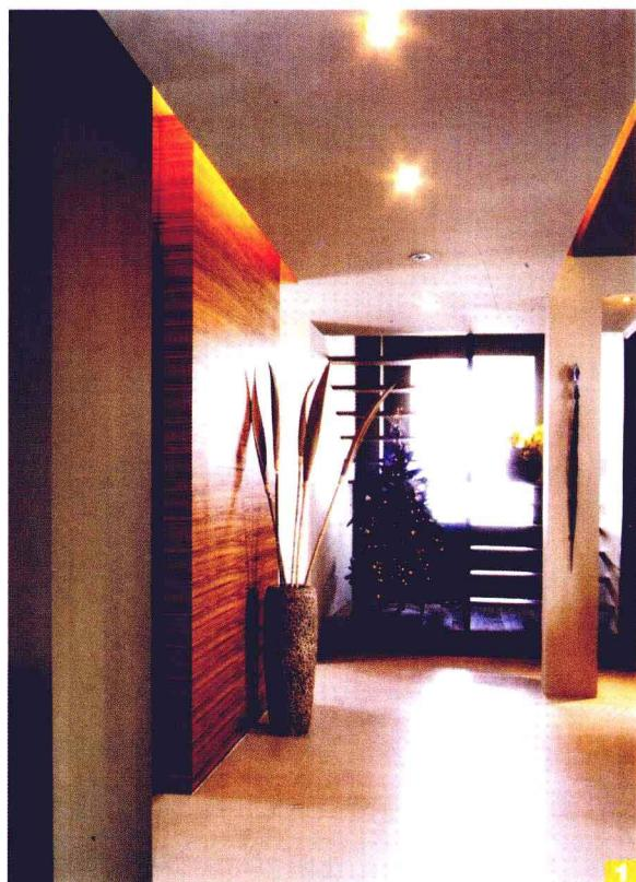
**1** 过道墙面为饰面板材质。施工做法为：先用木龙骨做出框架。之后用大芯板做为底材，表面贴装饰饰面板，最后饰面板表面刷哑光清漆。整体造价大约在280元/平方米。
