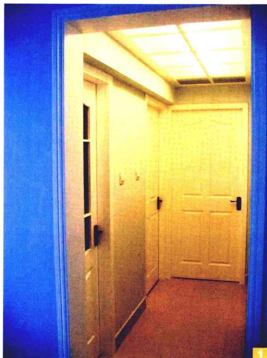
**1** 过道石膏板及磨砂玻璃材质。施工做法为：先用木龙骨做出框架及结构，之后骨架要做防虫、防火处理。电路施工要同步完成，之后用石膏板封面，自攻螺钉固定，钉眼做防锈处理。然后按设计图纸封磨砂玻璃，最后石膏板刷乳胶漆。整体造价大约在170元/平方米。
