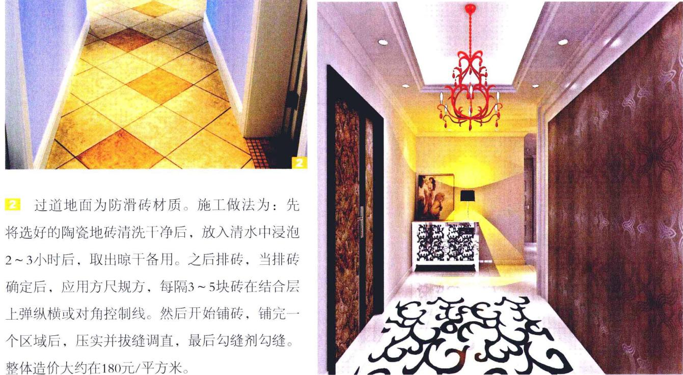
2 过道地面为防滑砖材质。施工做法为：先将选好的陶瓷地砖清洗干净后，放入清水中浸泡2~3小时后，取出晾干备用。之后排砖，当排砖确定后，应用方尺规方，每隔3~5块砖在结合层上弹纵横或对角控制线。然后开始铺砖，铺完一个区域后，压实并拔缝调直，最后勾缝剂勾缝。整体造价大约在180元/平方米。
