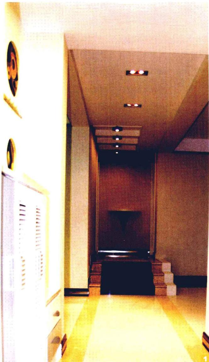
**1** 吊顶为石膏板材质。施工做法为：先用木龙骨做出框架及结构，之后用石膏板封面，自攻螺钉固定，然后按设计图纸用石膏线为造型包口，最后石膏板表面刷乳胶漆。整体造价大约在125元/平方米。
