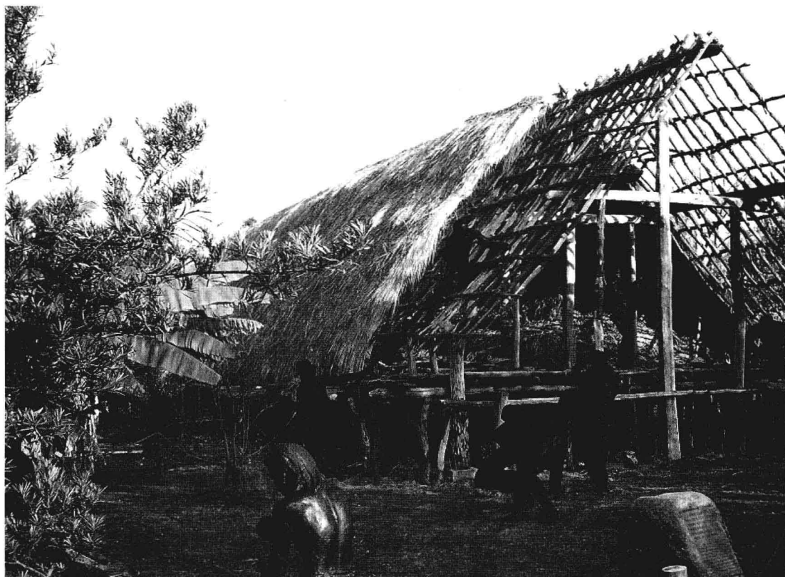
图 1.11 河姆渡干栏建筑结构复原图
