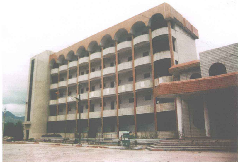
六枝一中教学综合实验楼
