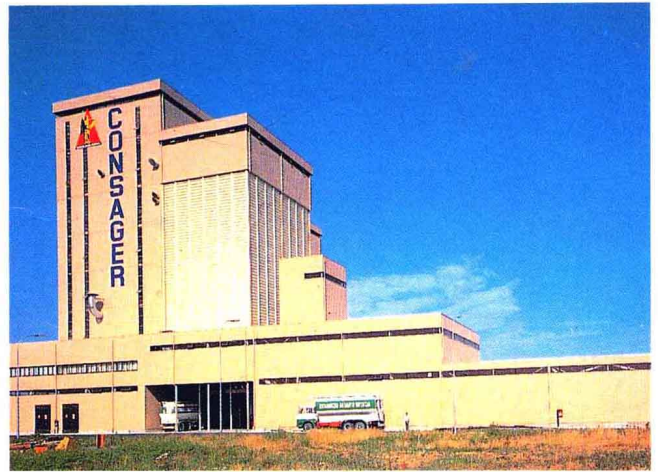
3. 意大利的用户:Consorzio Agrario Provinciale di Brescia 全套 PLC 微机控制的饲料加工生产线 产量:每小时 50 吨,同时提供 1.05 万吨的原料仓及 4000 吨成品库
