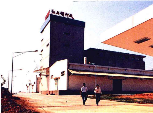
2. 中国的用户:民星企业集团江西饲料厂(南昌) 全套 PLC 微机控制的饲料加工生产线。 产量:每小时 22.5 吨
