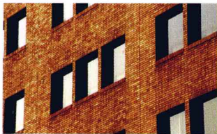
现代建筑平整光洁的清水砖墙。
