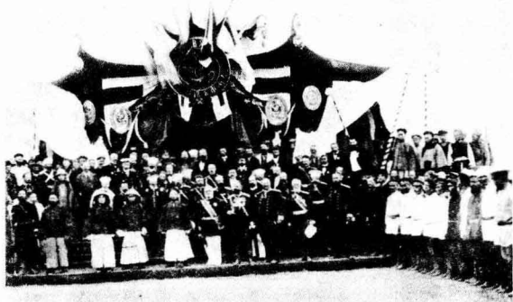
1897年8月,东清铁路(西起满洲里, 东至绥芬河)开工仪式
