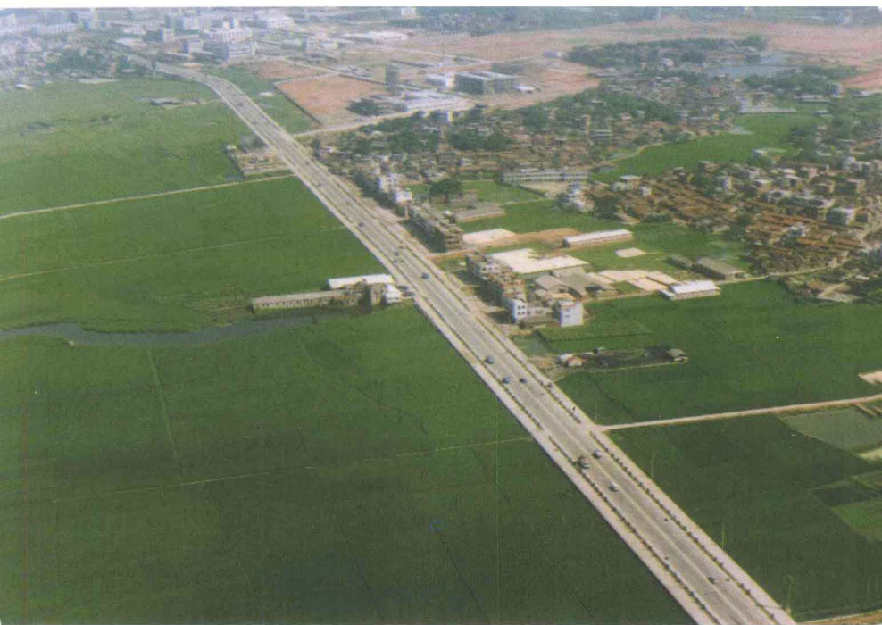
6.拓宽改造后的国道319线漳州段新貌
