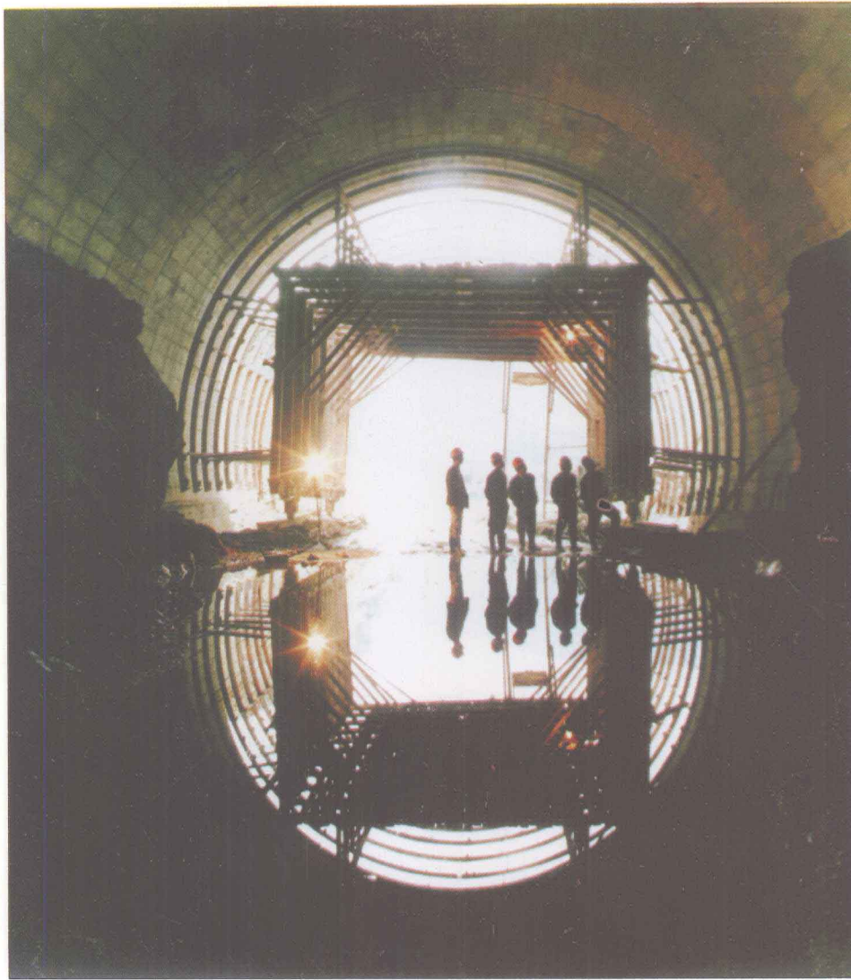
11.省道三郊线重点工程“石马岬隧道”工地
