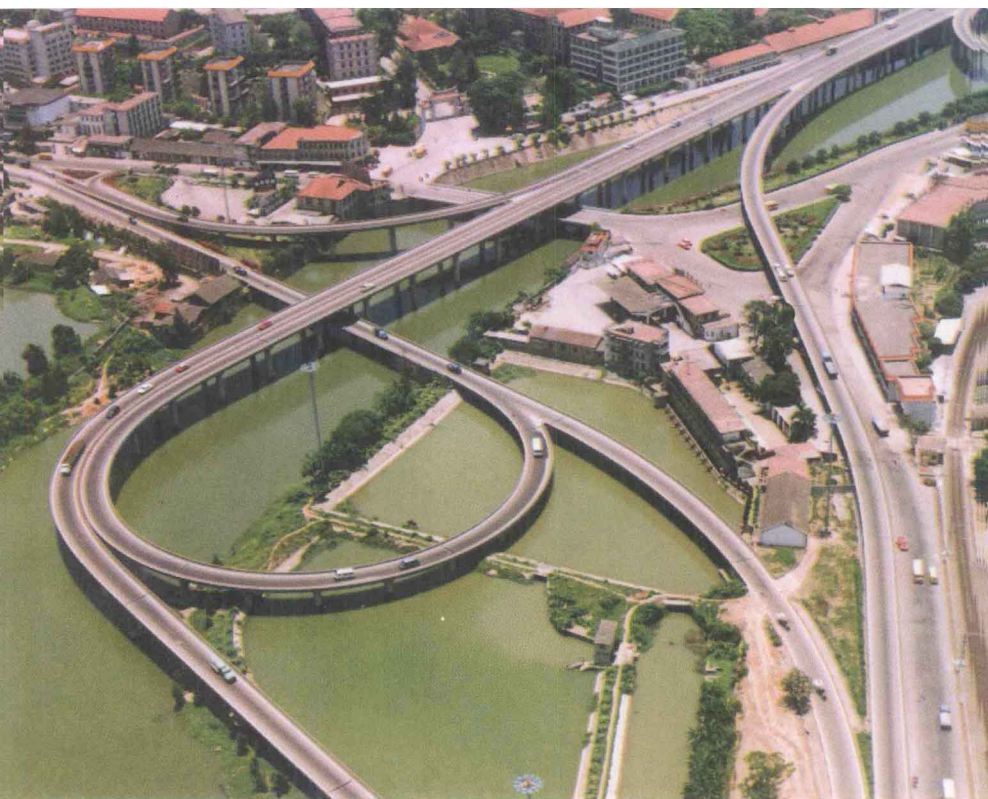
14.国道319线起点厦门跨海大桥接线雄姿
