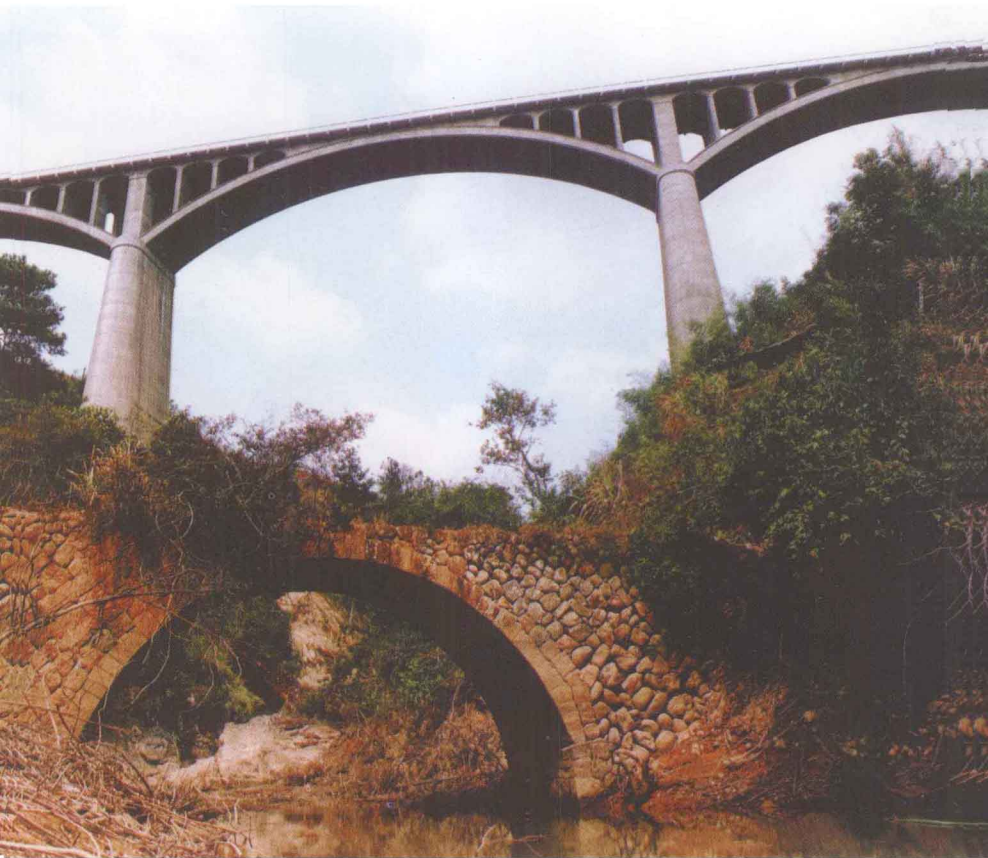
12.修建国道断头路316线南平段樟湖板大桥雄姿
