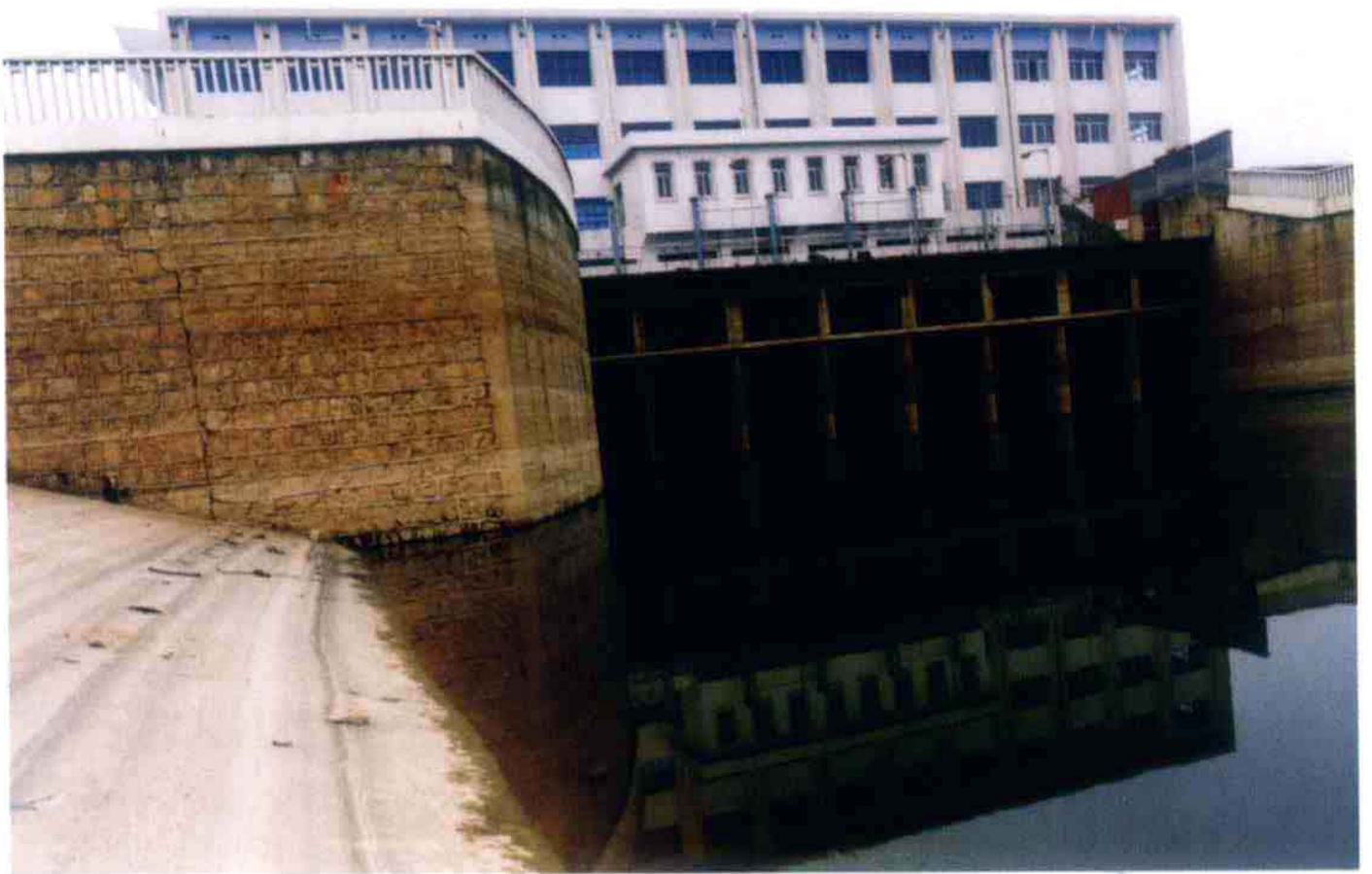
▲ 泥河水利枢纽工程
