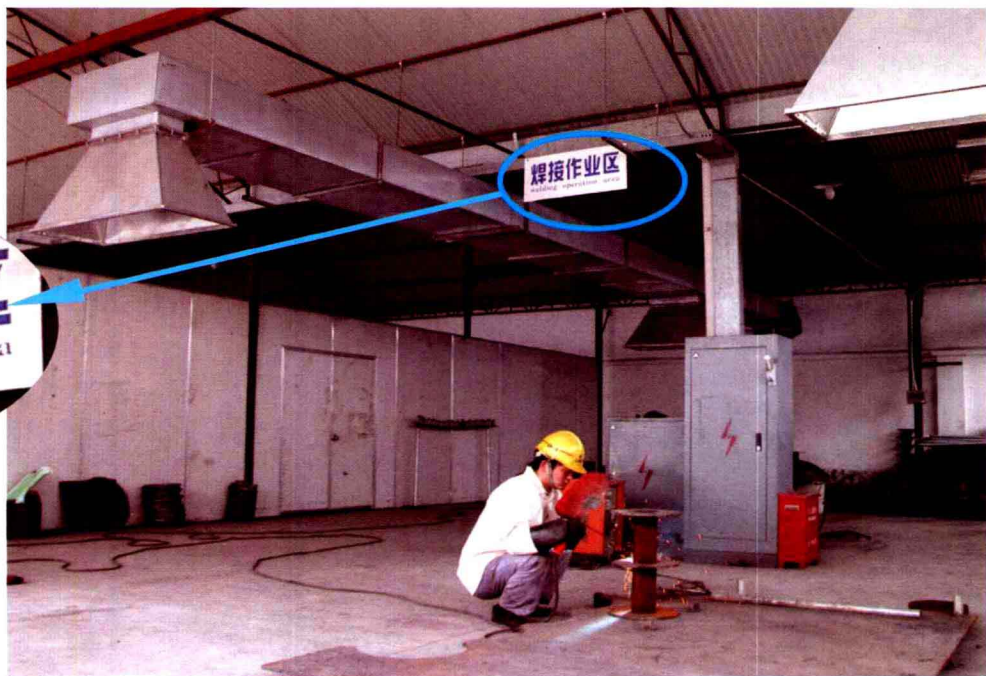
管道安装施工现场实行绿色施工，管线实行“工厂化”预制。 (上海市安装工程有限公司)
