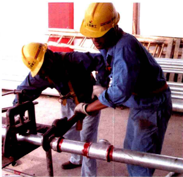
工人们在预制场内进行管道批量加工。 (上海市安装工程有限公司)
