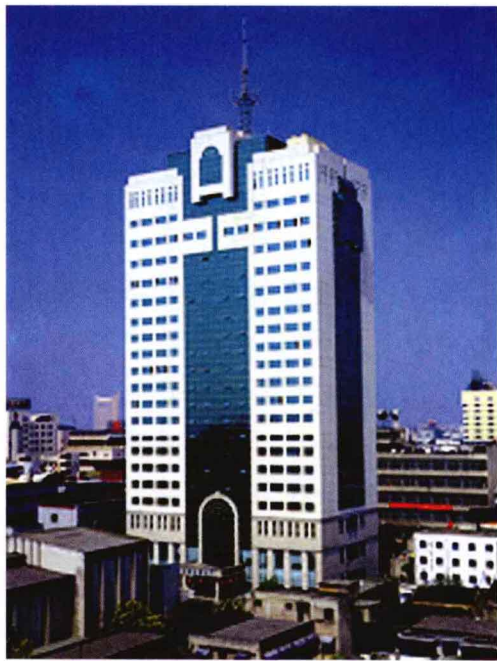
图6 绍兴市移动通讯综合楼 获鲁班奖
