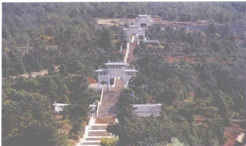
韶山藏书楼 800米的石台阶 和石牌坊
