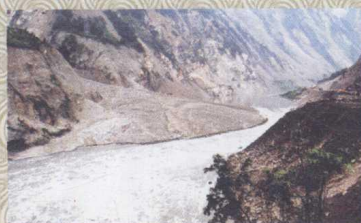
➔ 搶通都汶生命線。2008年8月3日，龍口河段擴寬了，使得壅塞體段搶通公路防洪能力達到50年一遇。
