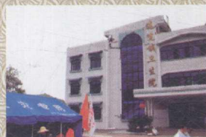
↑ 地震損毀的衛生院。
