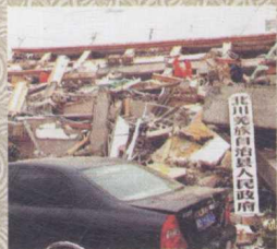
↑ 地震後倒塌的北川羌族自治縣政府大樓。
