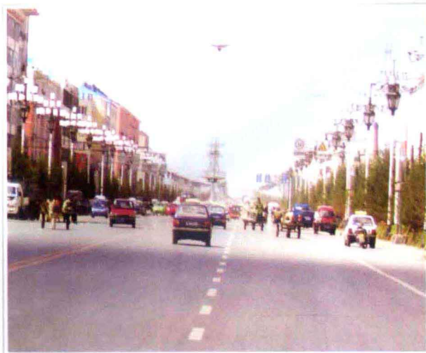
乾安鎮梧桐大路
