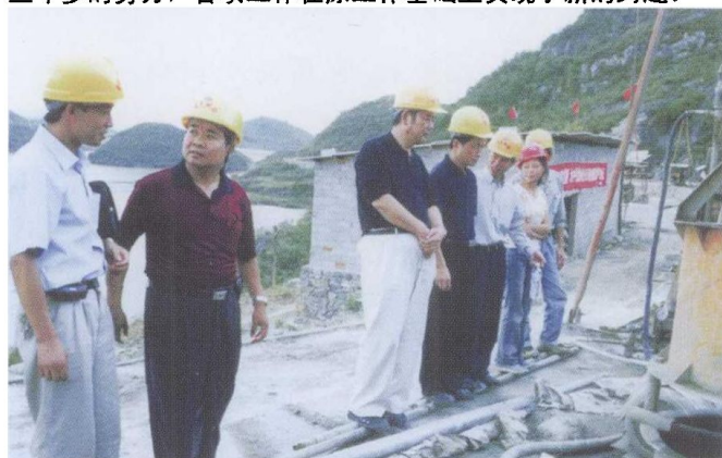
局领导视察帷幕灌浆施工工地（左二：副局长曾祥忠，左三：局长武国辉，左四：副局长董家龙）
