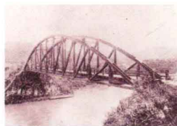
■與獅球嶺隧道完工年代相近的基隆河鐵路桁架橋。
