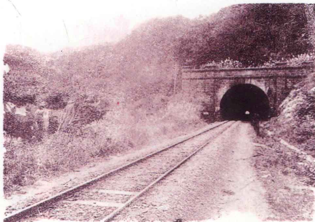
■日據初期改良基隆至台北間的鐵道，其中包括興建竹仔寮隧道取代獅球嶺隧道。竹仔寮隧道較大，為準備鋪設雙軌之用。
