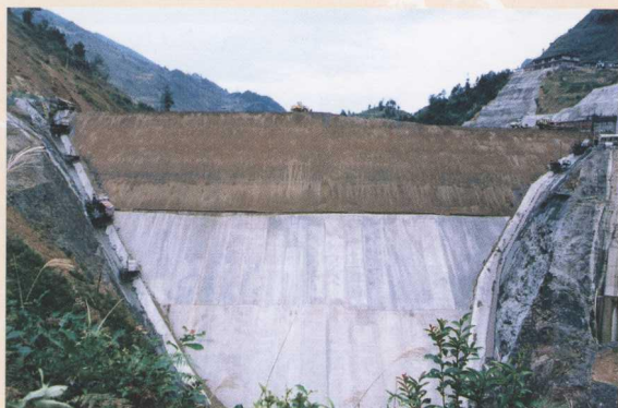
▲ 建设中的大水沟水库大坝。
