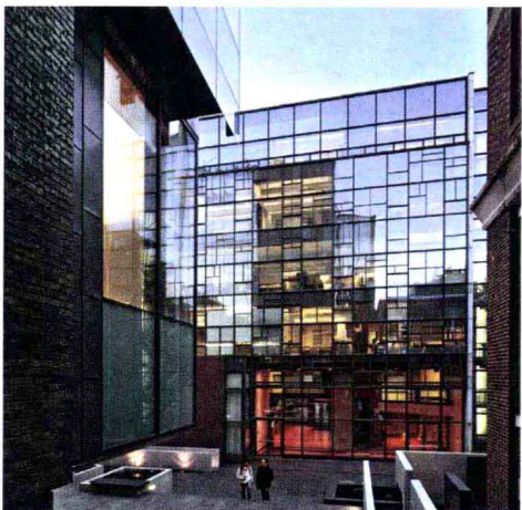
5 宾夕法尼亚大学的Levine礼堂，费城，2003年。在北美地区建造的第一道主动式节能幕墙。
