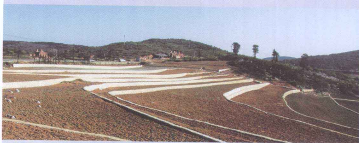
威宁乌江源坡改梯工程
