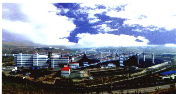
平朔洗煤厂全景
