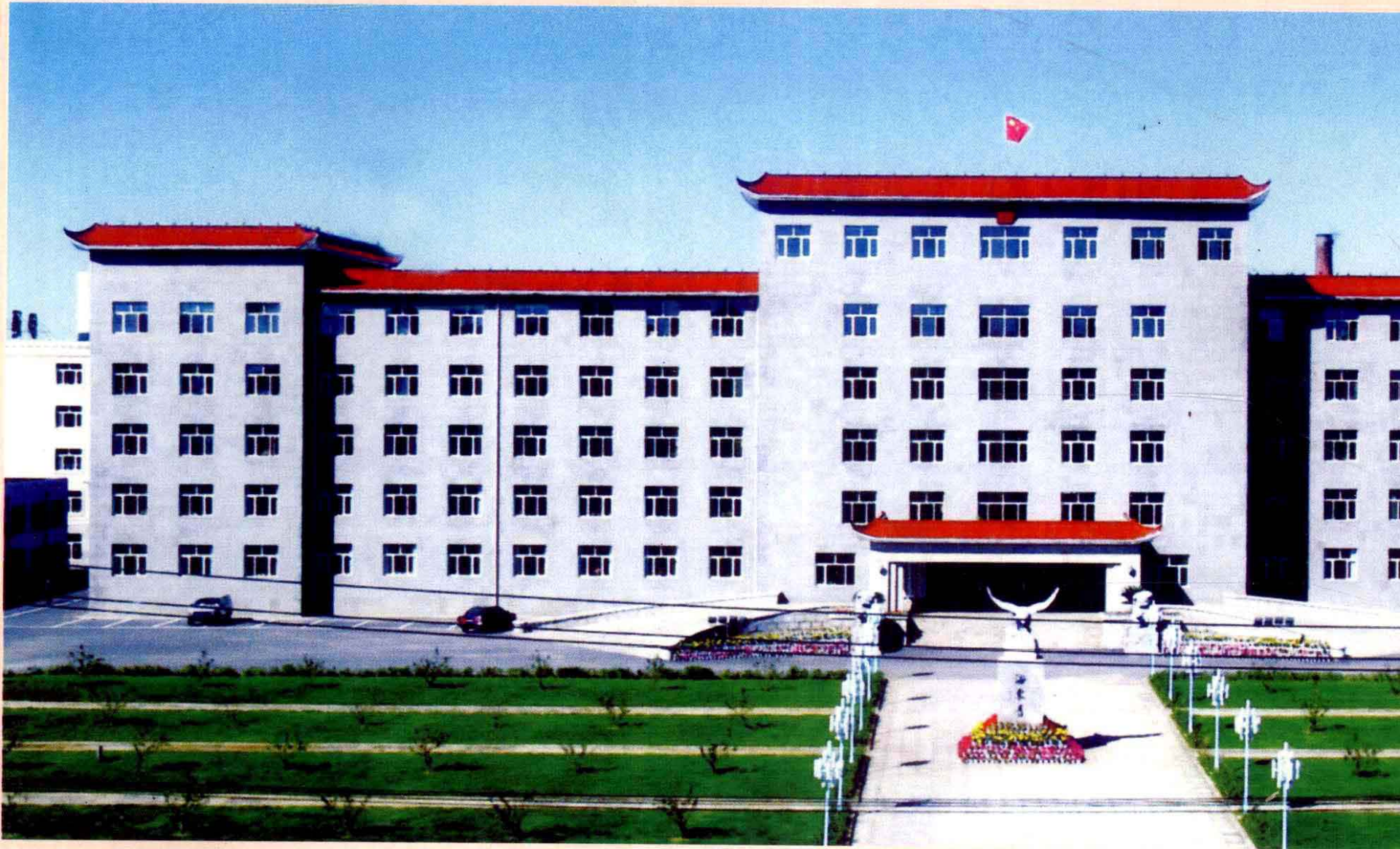
中共伊通满族自治县委、县人大、县政府、县政协、县纪检委办公大楼
