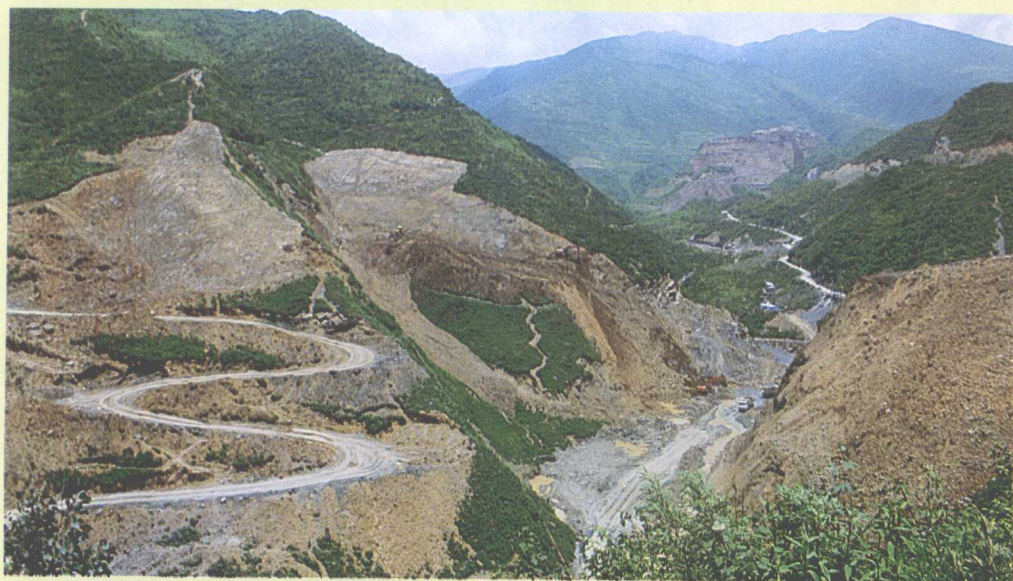
◀ 正在建设中的云养水库
