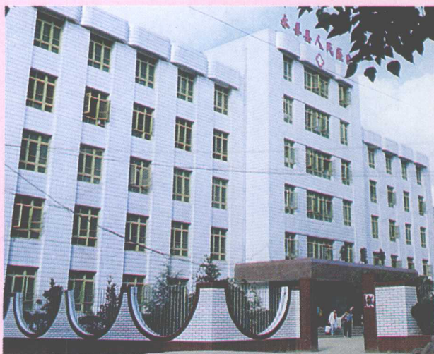
▲ 县人民医院住院部
