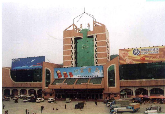
中铁五局建筑公司五分公司承建的遵义火车站站房
