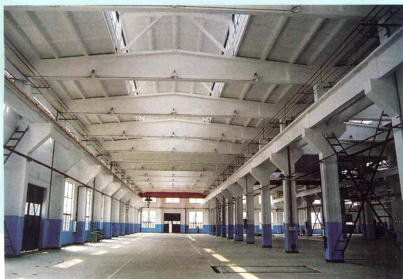
中铁五局建筑公司五分公司承建的061系统天科厂房
