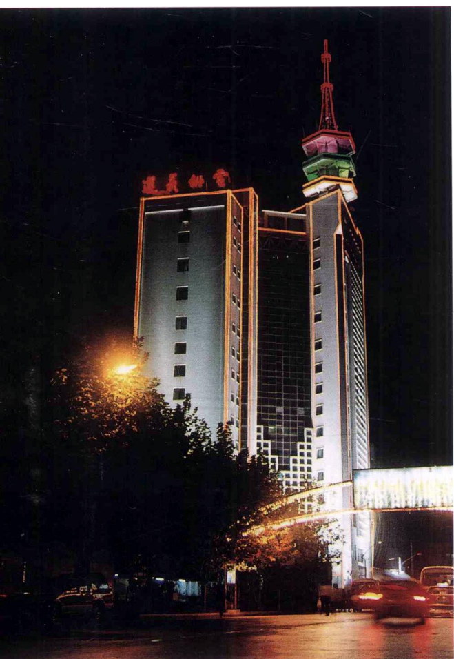
中铁五局建筑公司五分公司承建的遵义供电大楼
