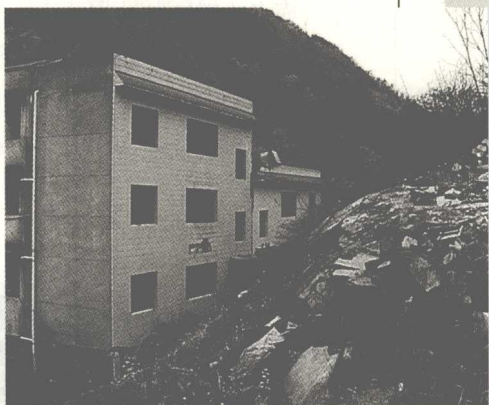
地震中没有被损坏的房子
