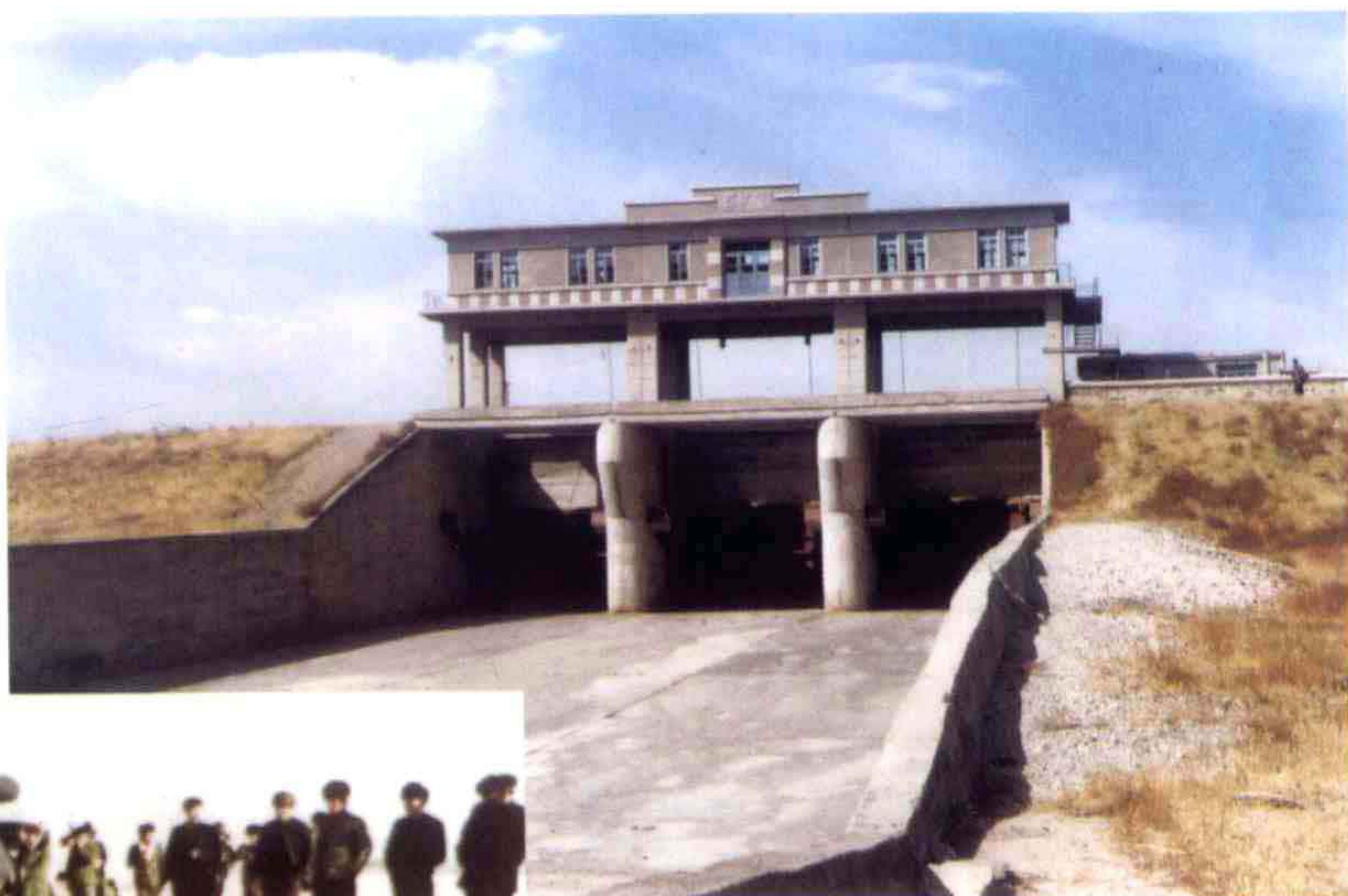
群昌水库溢洪道闸门
