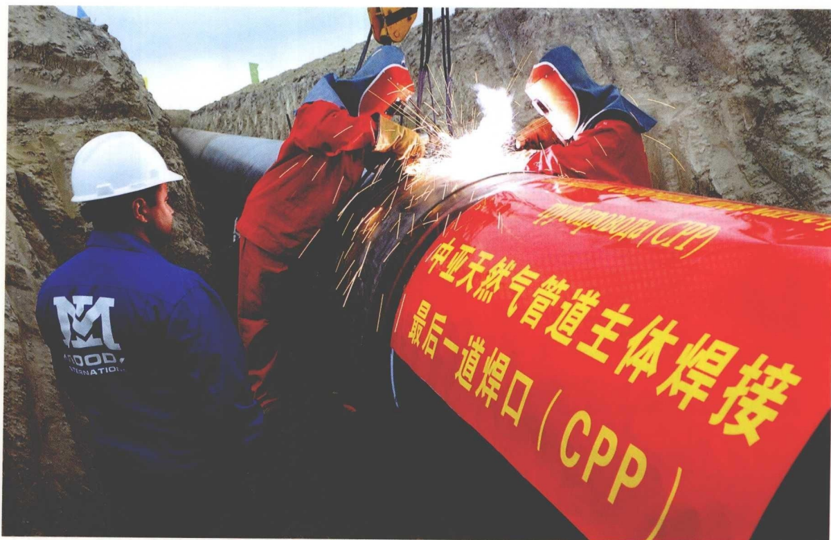
2009 年，我国第一条引进境外天然气的陆上能源大动脉——中亚天然气管道一期工程建成投运，西气东输二线西段同步建成投产，来自土库曼斯坦的天然气正式进入祖国境内。图为中亚天然气管道主体焊接最后一道焊口
