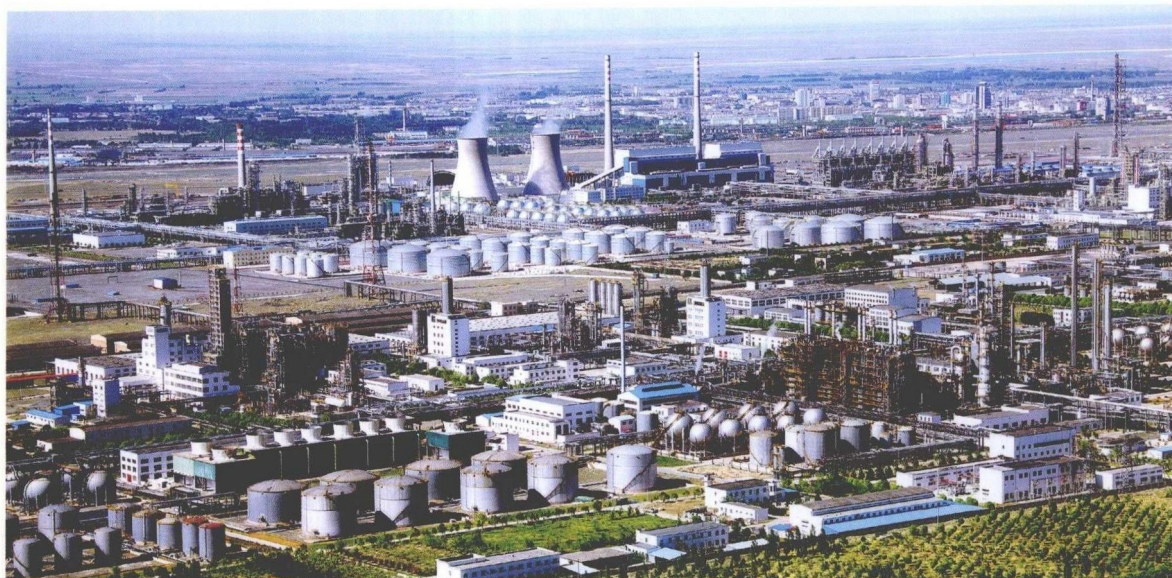
2009 年，中国石油天然气集团公司全年生产乙烯 299 万吨。图为独山子石化千万吨炼油百万吨乙烯工程
