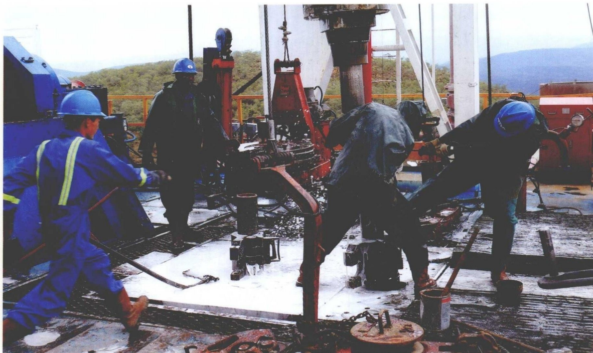
2009 年，中国石油天然气集团公司工程技术服务和工程建设业务服务保障能力不断提高，装备制造业务产业升级步伐加快。图为长城钻探公司在肯尼亚地热井施工现场
