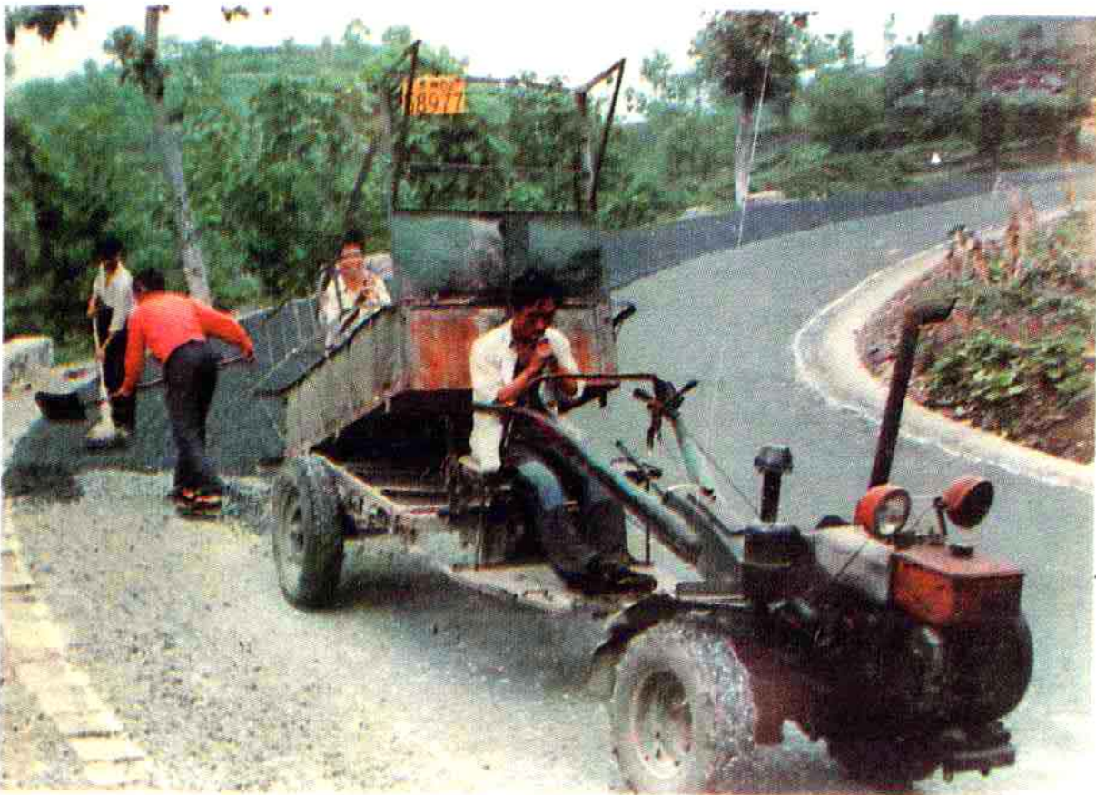
养路工人 鋪沥青路面
