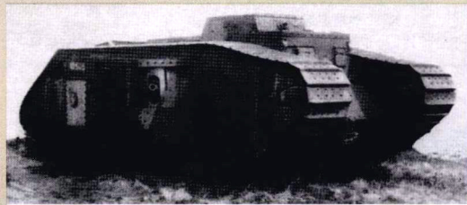
马克4型坦克改进型，加大了车顶指挥舱。
