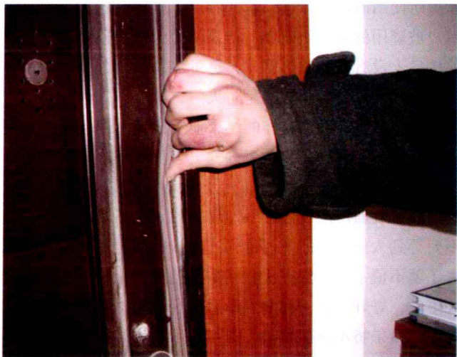
图 1-1 坏的门框密封条
