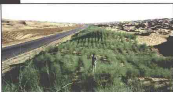
照片10 咸水灌溉下的塔克拉玛干沙漠公路的生物防护体系
