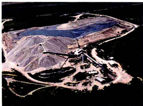
矿区的露天作业区
