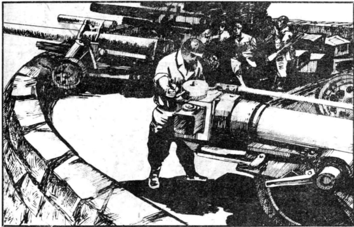
9、这马奇诺防线，每个防御区域由许多火器据点聚结而成，各据点相互配合构成火力网封锁通道，并设置障碍物阻挡坦克逾越，防线的一应火器都置于旋转的钢塔内，能左右旋转，侧射据点之间的死角。
