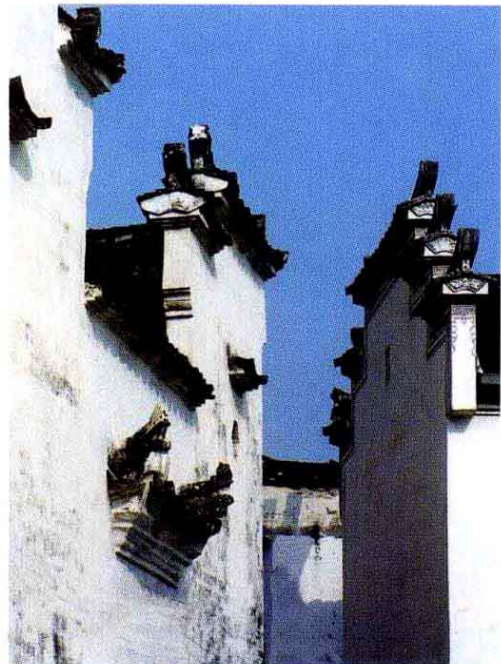
关麓村住宅马头墙 (楼庆西摄)
