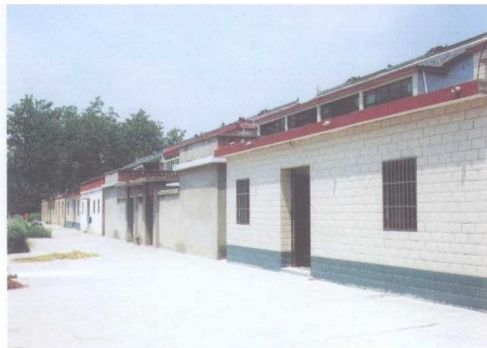
夏庄组居民点一角
