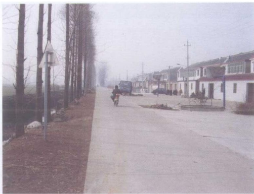
312县道平桥段纵贯陆桥村
