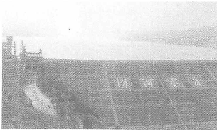
汾河水库大坝
