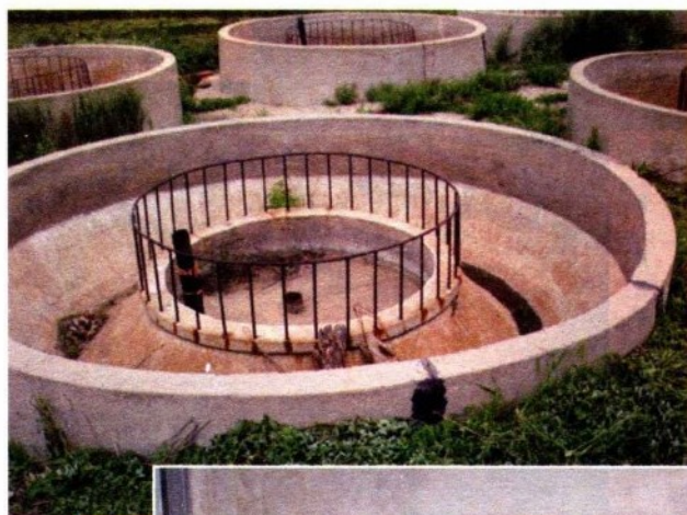
水泥池孵化环道
