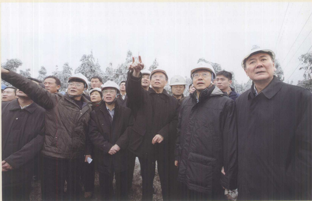
2008年2月2日，国务院副总理曾培炎率国务院工作组赴贵州指导雨雪冰冻抗灾救灾工作。图为曾培炎在筑观兴双回抢险救灾工地视察。(贵州电网公司供稿)
