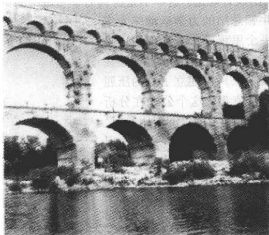
图1-11 尼姆城的加尔河谷输水道桥
