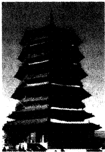
图1-5 山西应县木塔
