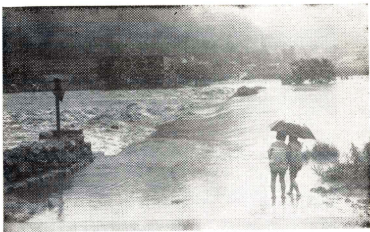
洪水淹没了董家堰石桥
