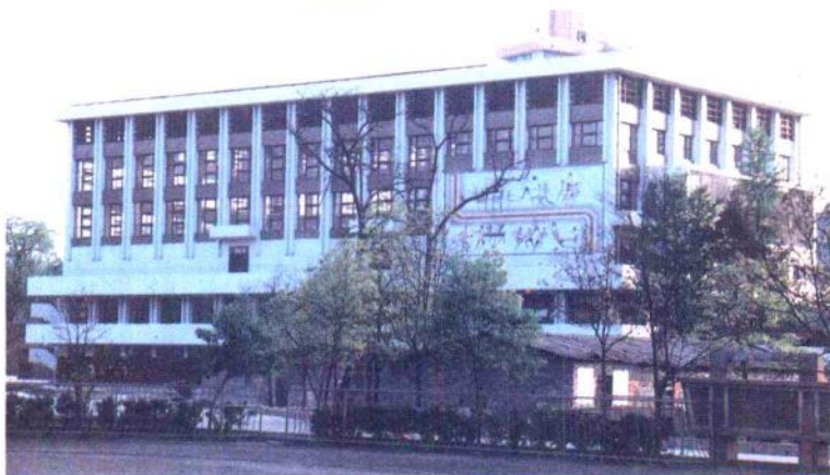
贵阳一中体育训练馆 (1989年竣工)。
