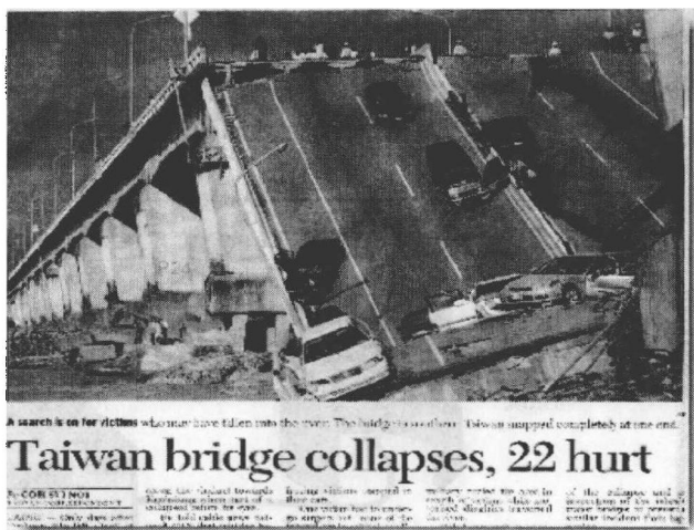
图 1.3 台湾大桥倒塌时的图片
