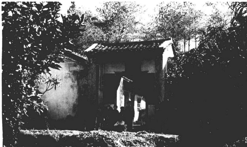
下增祖堂屋 垂裕堂外大门
