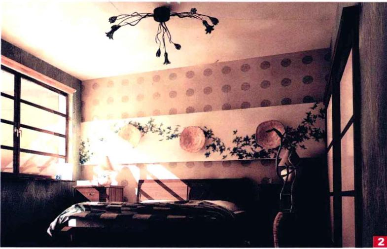
**1** 主题墙为装饰壁纸材质。施工做法为：先在主题墙中部按照设计图纸用木龙骨做出造型框架，之后用石膏板封面。然后用壁纸胶把装饰壁纸粘贴在墙面上，最后造型表面刷白色乳胶漆，干燥后手工绘制出设计图案。整体造价大约在170元/平方米。
