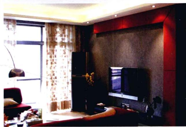
**1** 主题墙为饰面板材质。施工做法为：先用大芯板作为底材，用钢钉固定在墙上，表面贴装饰面板，施工时要把饰面板按设计要求裁切成相应大小，用汽钉固定，各饰面板块之间留5毫米缝隙，然后饰面板表面刷哑光清漆，最后用黑色勾缝剂勾缝。整体造价大约在300元/平方米。
