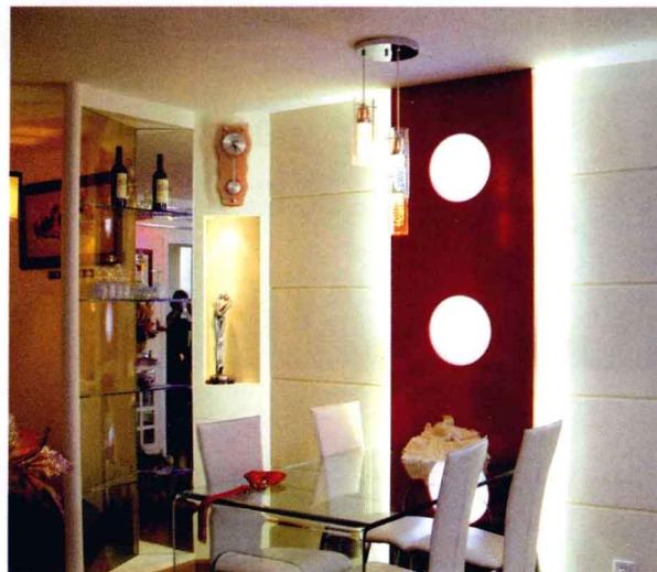
**1** 主题墙为装饰饰面板材质。施工做法为：先用木龙骨按照设计要求在墙面上做出框架，木龙骨与墙面用钢钉固定。木龙骨与墙面要留一定的空隙以便电器线路走线时用。之后用大芯板作为底材封底并预留走线空隙，然后用饰面板封面并刷哑光清漆。注意封饰面板前主题墙内电路施工要同步完成。最后用成品实木线条收边。整体造价大约在1350元/项。墙面砖采用了水泥砂浆铺贴施工工艺，整体造价大约在180元/平方米左右。
