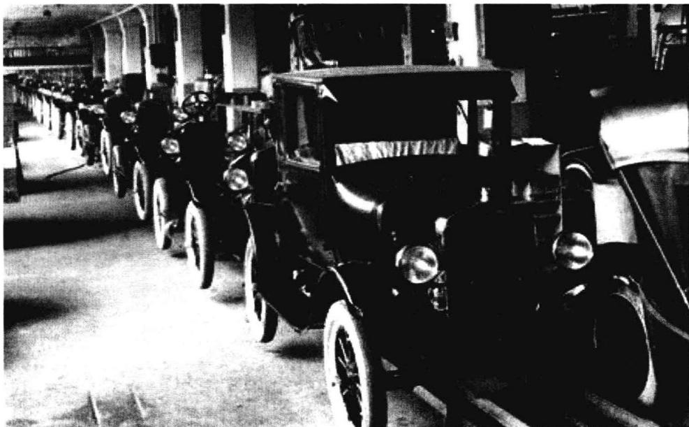
一条流水线创造了史无前例的生产模式，福特制做到了！福特制是由美国汽车大王亨利·福特在1913年创立的流水线模式，福特公司的流水线不但被誉为流水线的鼻祖，而且被称为福特制。福特制是典型的大工业生产的组织模式，代表了传统机器大工业生产的最高水平。福特制是通过生产组织形式与生产管理改进，提升了生产效率所取得的制度创新。工业时代的主题是追求更多产量与创造更大市场。对此，泰勒进行了理论创建，福特则采取了实践上的行动。
